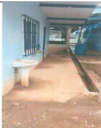
Foto 3: Reparación y sustitución de área de cocina.
