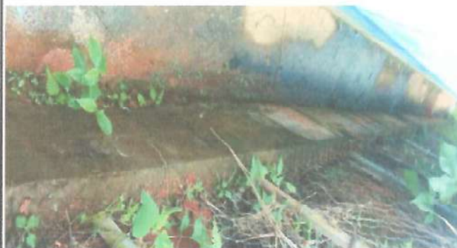
Foto 4: Reparación muro perimetral.
