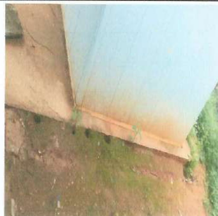
Foto 2: Reparación y sustitución de área de cocina.
