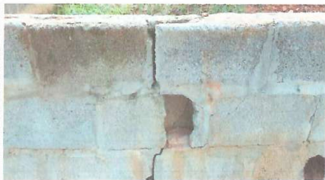
Foto1: Reparación muro perimetral.
