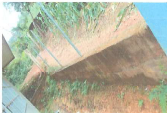
Foto 2: Reparación muro perimetral.
