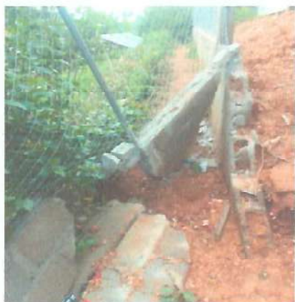
Foto 3 Reparación muro perimetral.
