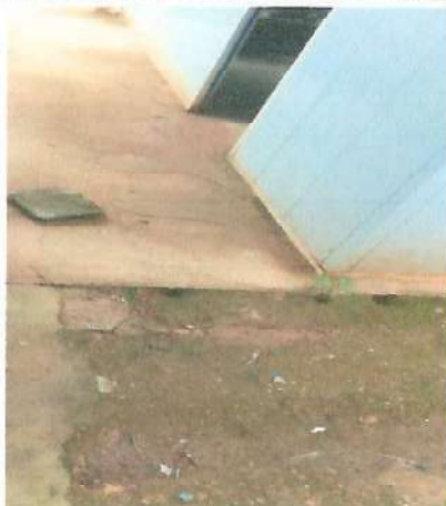
Foto 1: Reparación y sustitución de área de cocina.
